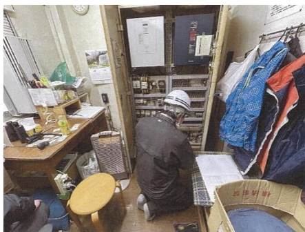
【インバータ・コンバータユニット整備工事】
